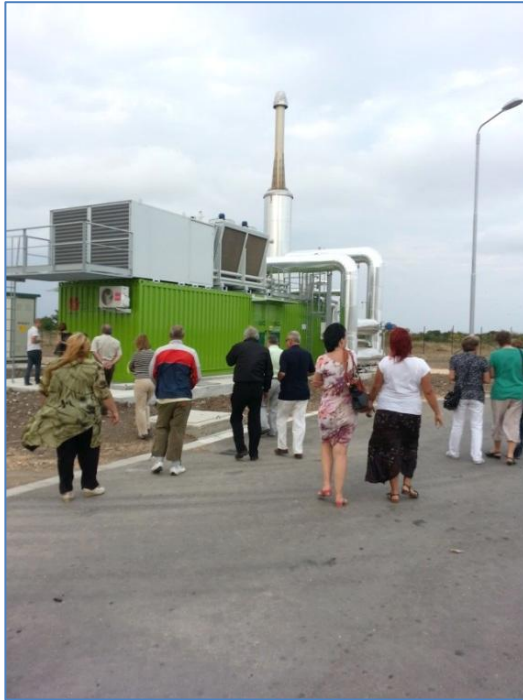
Krapetz-Dobrudha 2013; nowoczesna biogazownia w rejonie Szabla
